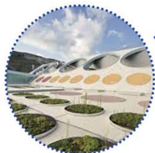
Centrale trattamento rifiuti, Barcellona
